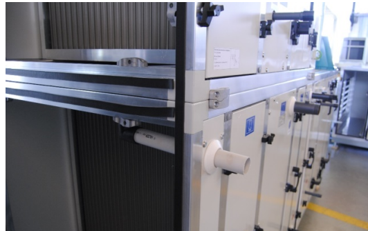
Kodensatablauf, wenn der Kühler im höheren Stock steht
