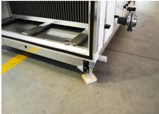
Kodensatablauf, wenn der Kühler im höheren Stock steht
