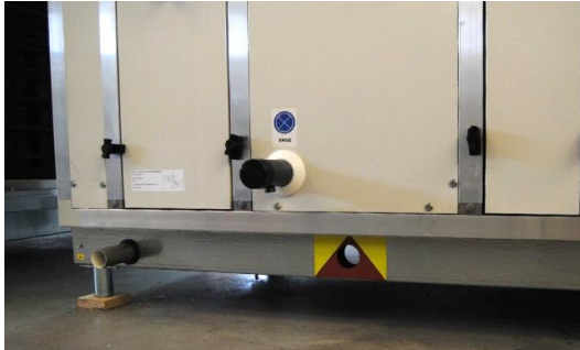
Ständer mit Ablaufrohr für Siphon und Löcher \varnothing 50mm
